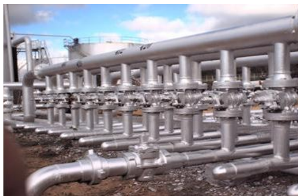
Figura 5.1.5: Colector de la batería.
